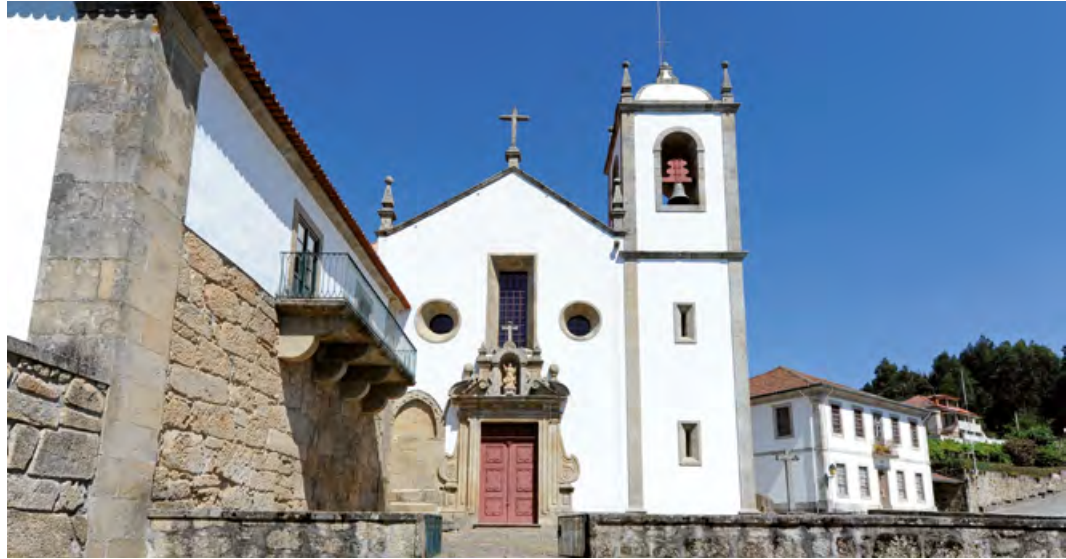
Monastery of Vila Boa do Bispo (Marco de Canaveses). West façade.
