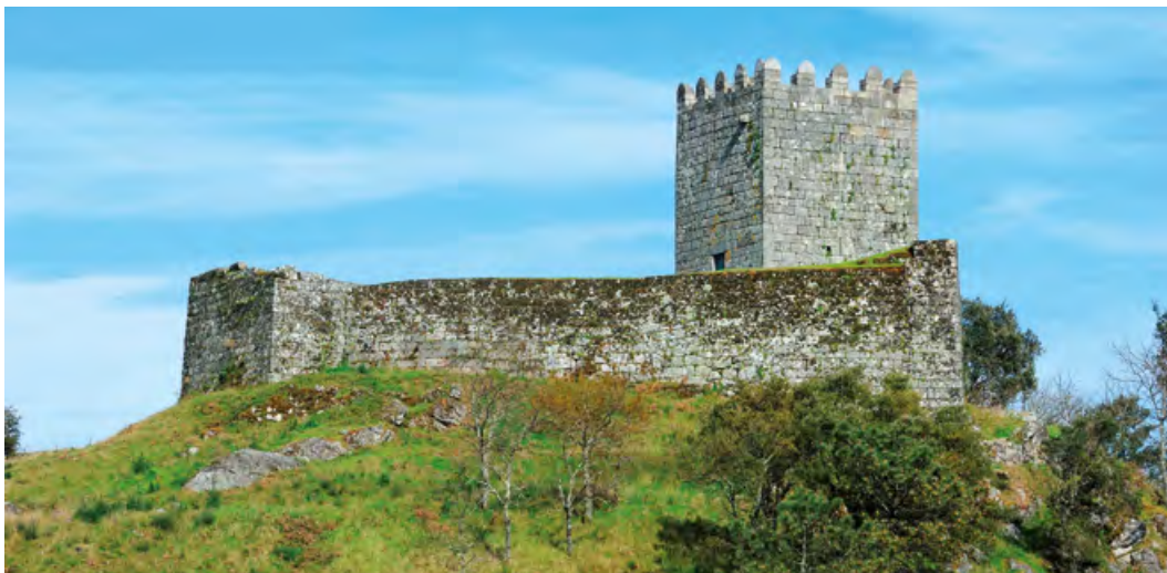
Castle of Arnoia (Celorico de Basto). West view.
