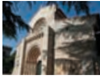
18. Mosteiro do Salvador de Paço de Sousa | Penafiel
