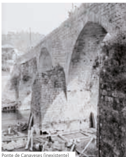
Ponte de Canaveses (inexistente)
