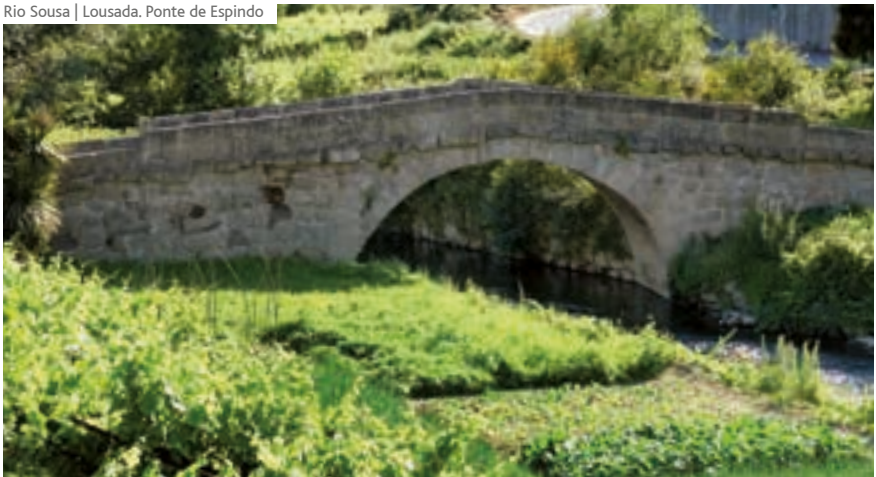
Rio Sousa | Lousada. Ponte de Espindo
