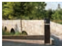
9. Ponte de Vilela | Lousada
