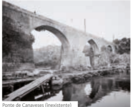
Ponte de Canaveses (inexistente)
