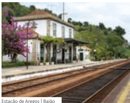
Estação de Aregos | Baião
