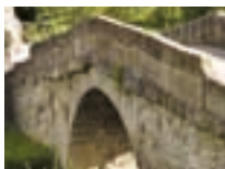
11. Ponte de Espindo | Lousada
