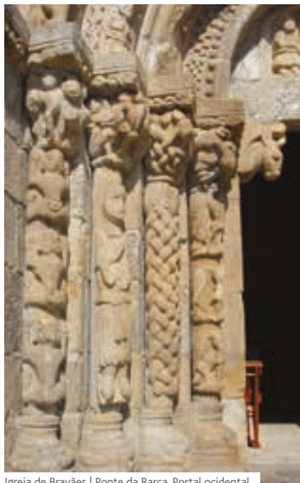
Igreja de Bravães | Ponte da Barca. Portal ocidental
