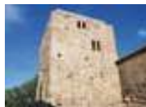
13. Torre de los Alcoforados | Paredes
