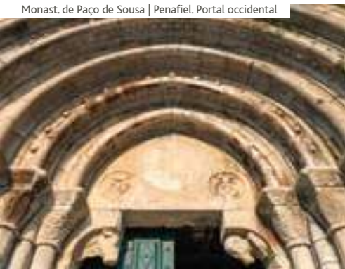
Monast. de Paço de Sousa | Penafiel. Portal occidental
