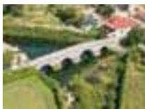
46. Puente de Fundo de Rua | Amarante
