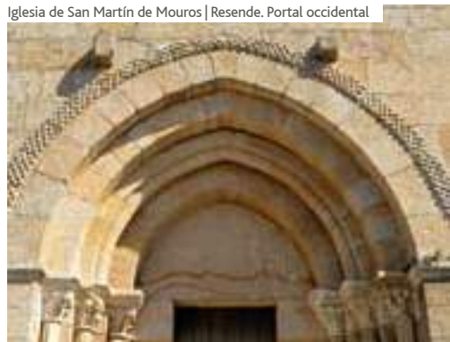
Iglesia de San Martín de Mouros | Resende. Portal occidental
