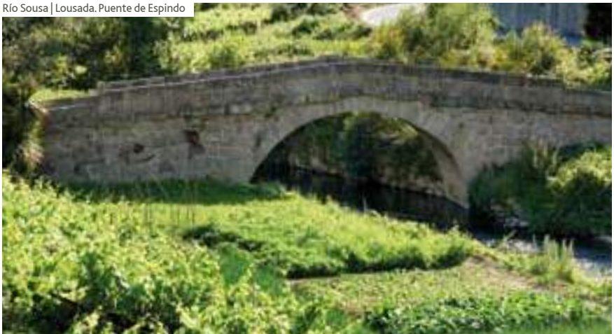
Río Sousa | Lousada. Puente de Espindo
