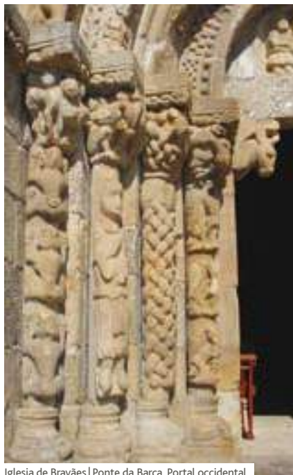
Iglesia de Bravães | Ponte da Barca. Portal occidental
