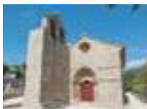
43. Iglesia del Salvador de Tabuado | Marco de Canaveses
