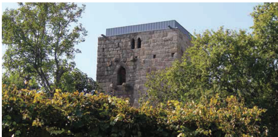
Fachada nordeste durante as intervenções da Rota do Românico (2014).
