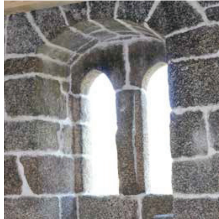
Fachada noroeste. Piso superior. Pormenor da janela mainelada. Vista interior.
