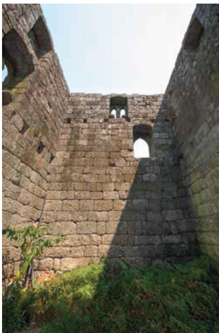
Vista geral dos paramentos interiores antes das intervenções da Rota do Românico (2014).
