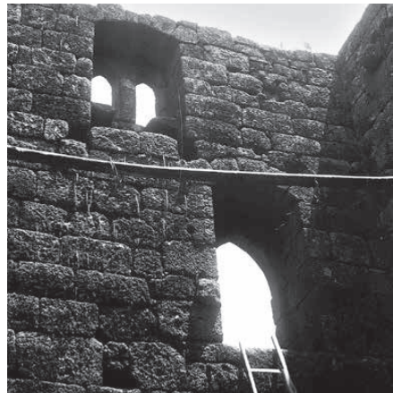
Fachada noroeste. Piso intermédio. Pormenor da janela mainelada (vista interior) (1951). Fonte: arquivo IHRU.
