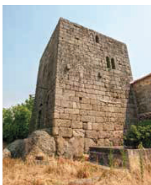
Vista geral antes das intervenções da Rota do Românico (2014).
