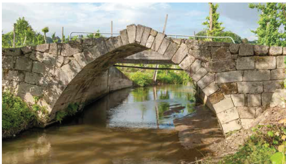
Vista de jusante.
