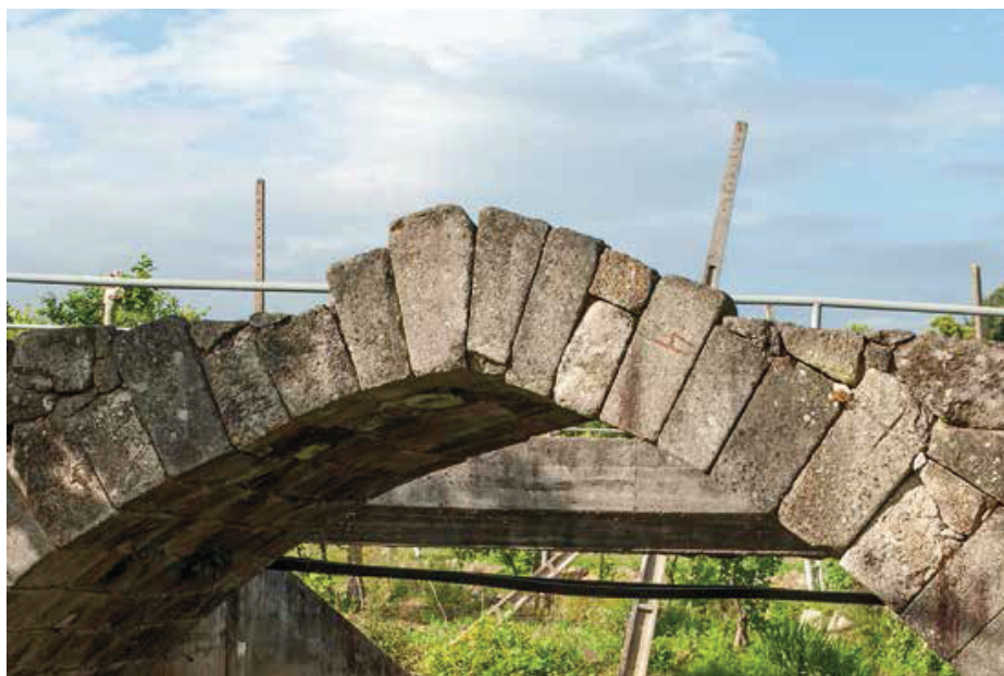
Vista de jusante. Remate do arco.
