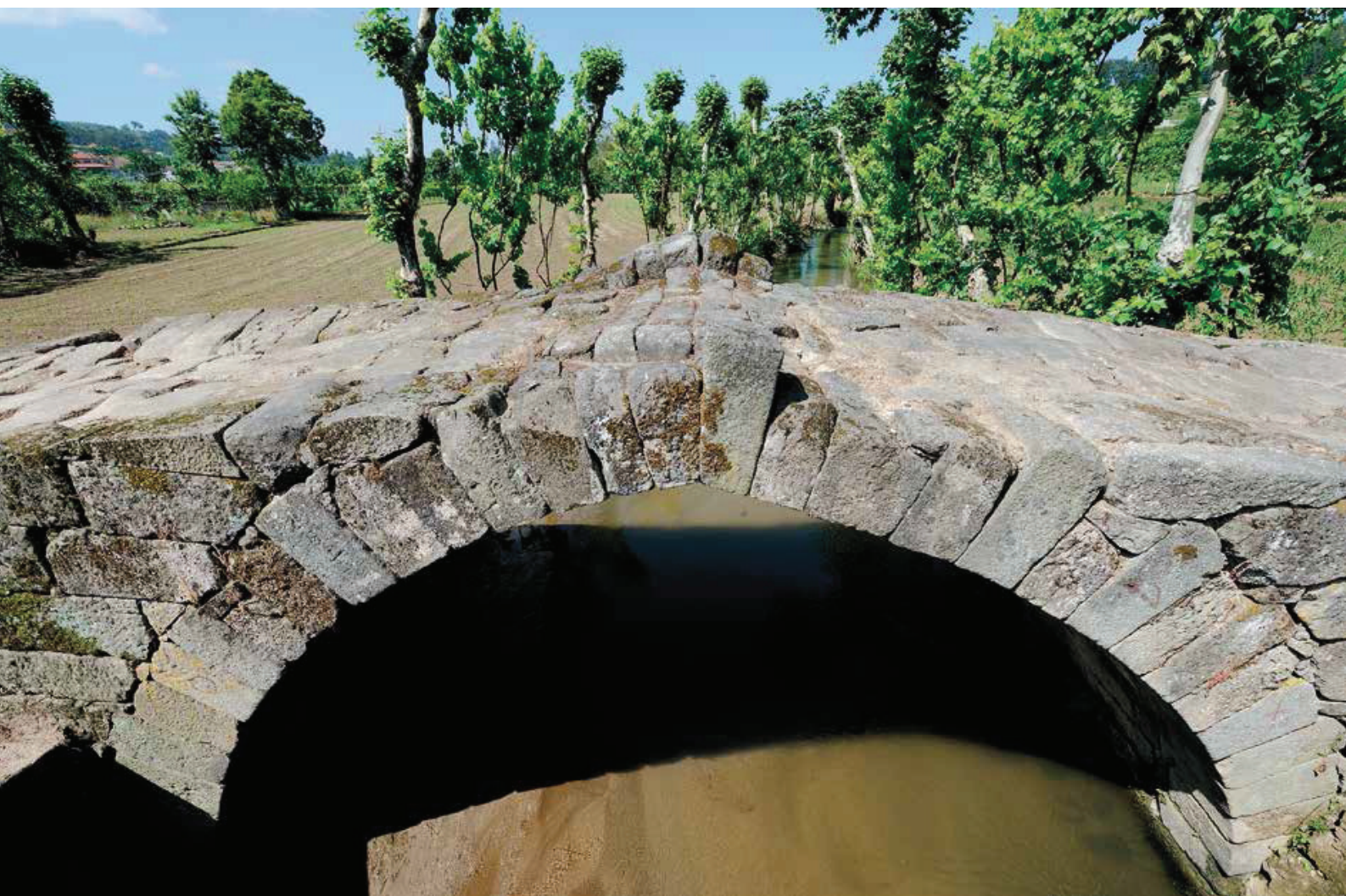
Vista de montante. Arco e tableiro.
