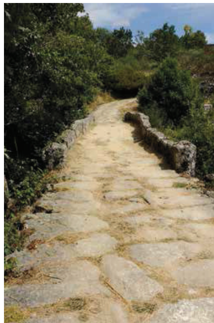
Calçada de acesso à Ponte.
