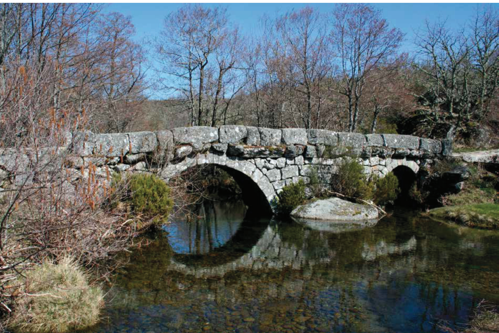
Vista de montante.
