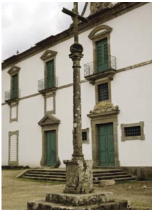
32. Fachada do Mosteiro, reformado na Época Moderna e Cruzeiro.
