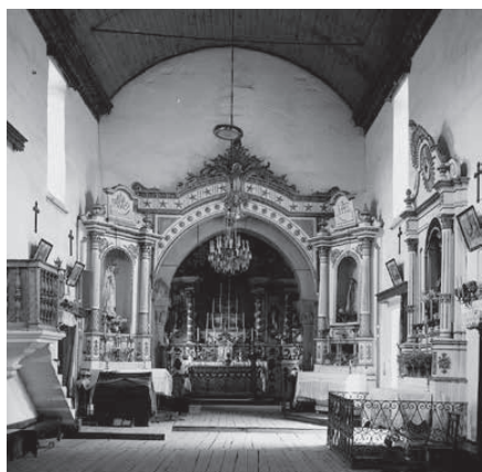
Igreja. Nave antes das intervenções da DGEMN (1968). Fonte: arquivo IHRU.
