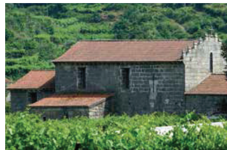
Igreja. Fachada norte.
