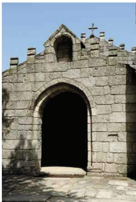
Igreja. Fachada ocidental. Galilé. Vista exterior.
