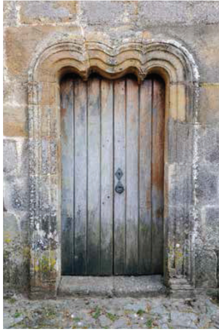
Igreja. Fachada norte. Nave. Portal.
