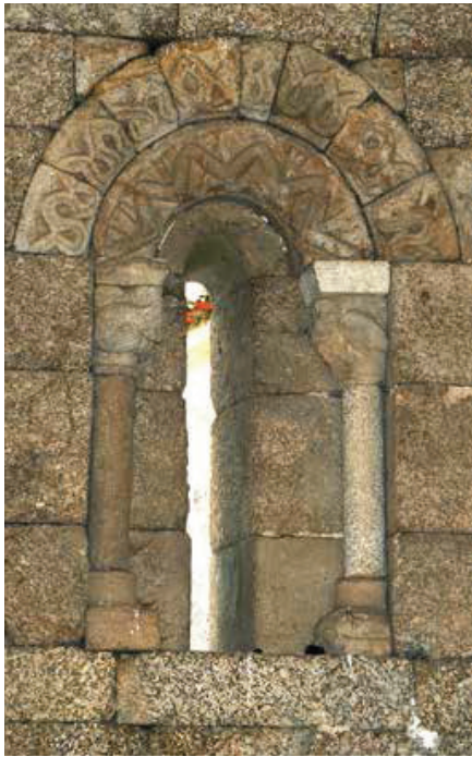
Panteão dos Resendes. Fachada oriental. Vista interior da fresta.
