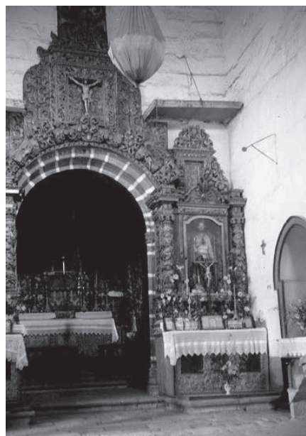
Igreja. Interior antes das intervenções da DGEMN. Fonte: arquivo IHRU.
