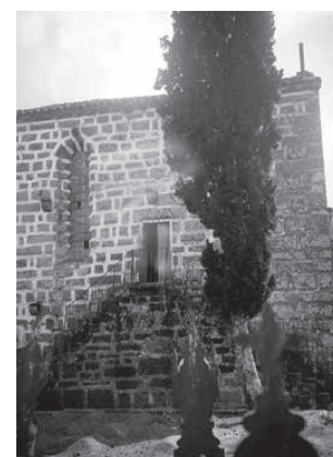
Igreja. Fachada norte antes das intervenções da DGEMN. Fonte: arquivo IHRU.
