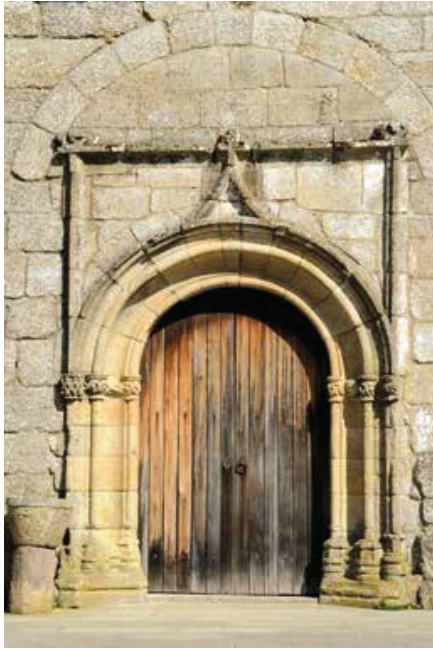
Igreja. Fachada ocidental. Portal.
