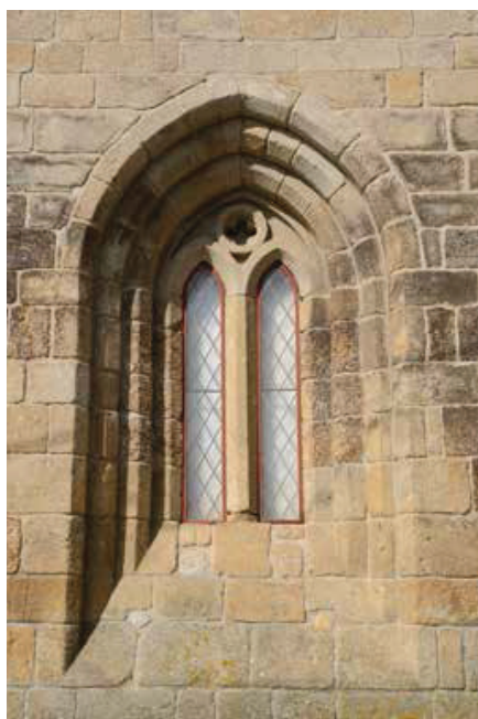
Igreja. Fachada oriental. Janela mainelada.
