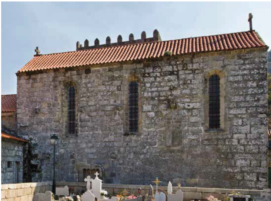
Igreja. Fachada norte.
