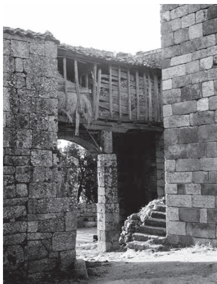
Passadigo existente sobre o arco que ligava a "Casa do Caseiro" ao "Conventinho" antes das intervenções da DGEMN (1955). Fonte: arquivo IHRU.
