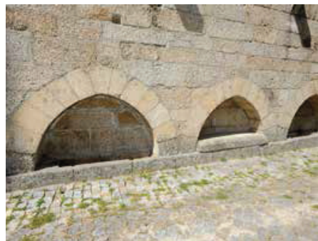
Igreja de Vila Boa de Quires (Marco de Canaveses). Fachada sul. Nave. Arcossólios.
