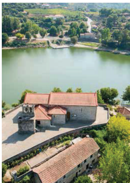
Igrejas de Sobretâmega e de São Nicolau. Vista aérea.
