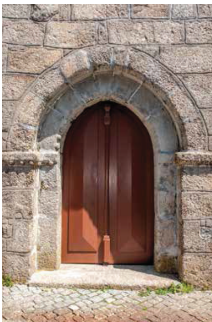
Fachada ocidental. Portal.
