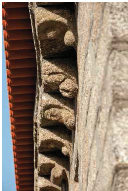
Fachada norte. Nave. Cachorros.
