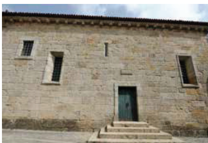
Fachada sul. Nave.
