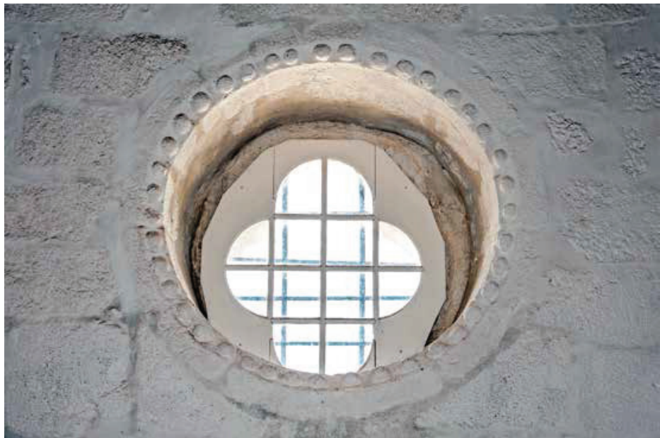
Fachada ocidental, Óculo (vista interior).
