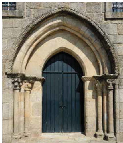
Fachada ocidental. Portal.
