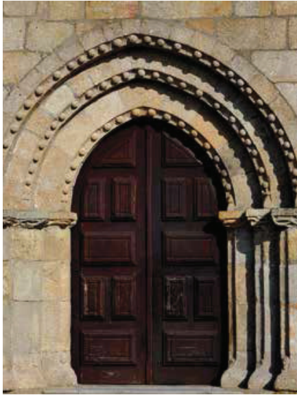
Fachada ocidental. Portal.
