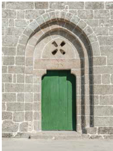
Fachada ocidental. Portal.
