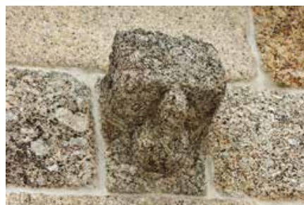
Fachada sul. Nave. Mísula.
