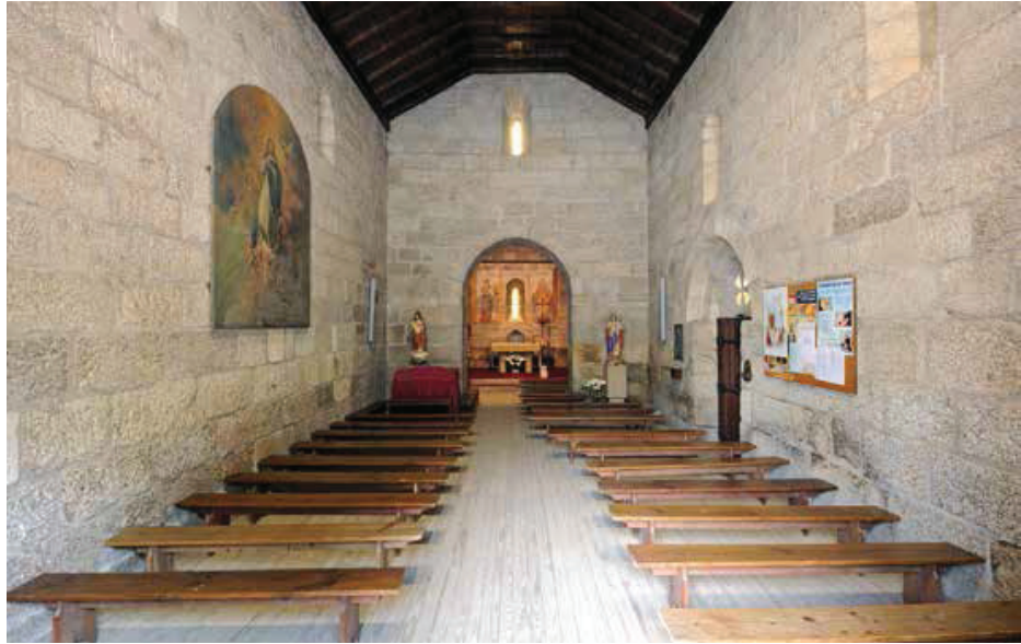
Vista geral do interior a partir da nave.
