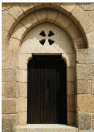
Fachada sul. Nave. Portal.
