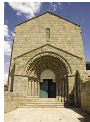
5. Fachada ocidental. Apresenta um portal inserido em estrutura pétrea, solução semelhante à das Igrejas do Salvador de Unhão, São Vicente de Sousa e Santa Maria de Airães.
